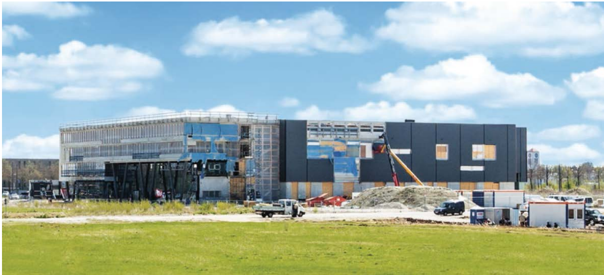
Abbildung 20: Blick auf das im Bau befindliche Technologiezentrum Augsburg
