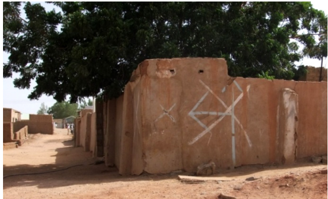
Photographie 23 : maison marquée par les autorités de planification pour démolition
