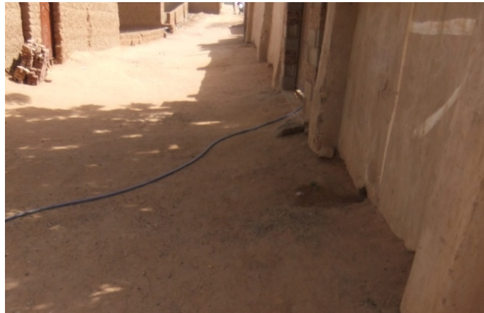
76 : dérivation du réseau à travers la rue à côté l'ouverture pour l'évacuation des eaux usées
