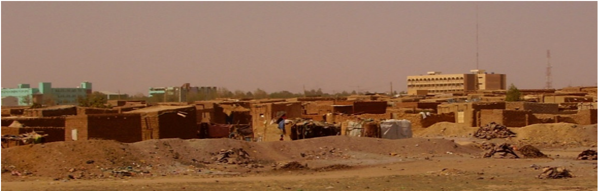
Photographie 12 : Vue vers le nord ouest du quartier de Zurgan
