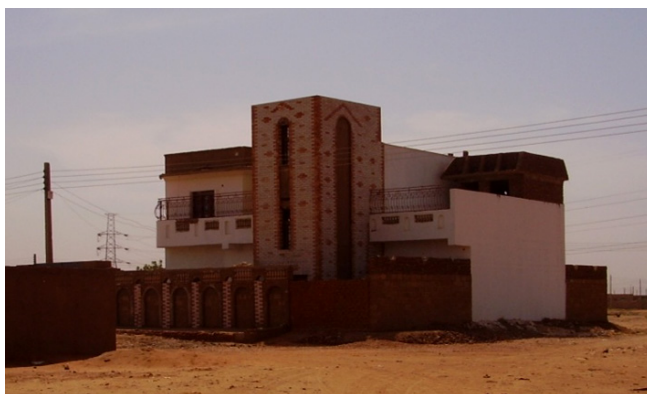
Photographie 28 Habitation à étage, type classe 1, en périphérie du bloc 57
