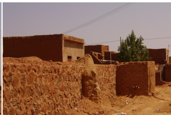
Photographie 29 : Habitation de classe 3, en briques artisanales, bloc 98
