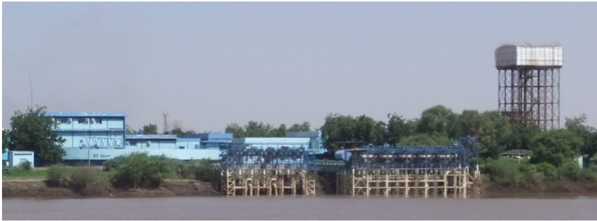
Photographie 33 : Station de pompage et de traitement sur le Nil Bleu à Khartoum Bahri
