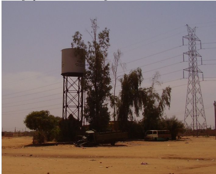
Photographies 52 et 53 : Forage et réservoir du bloc 57
