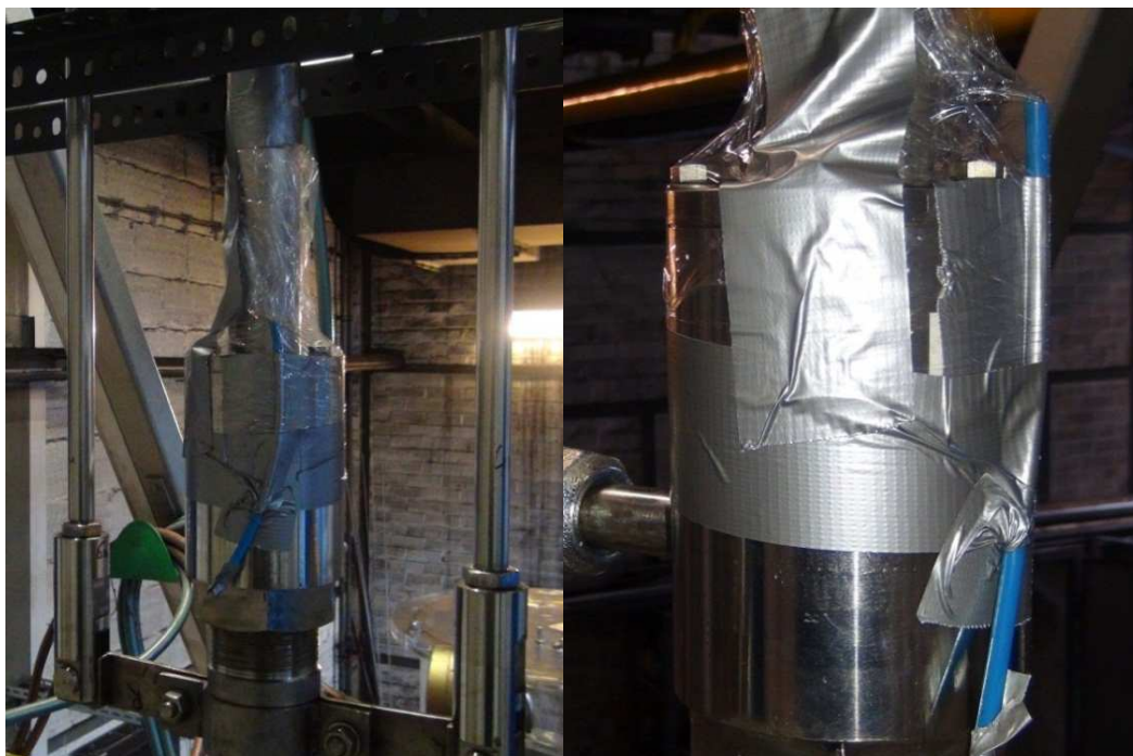
Abb. 5.16: Befestigung der Folie am Gestänge außerhalb des Krümmers, Druckausgleichsschlauch
