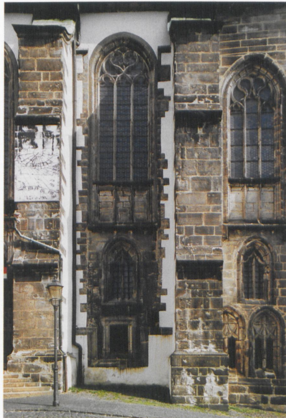
Abb. 4 Peterskirche Görlitz, Südfassade (Detail) mit den beiden westlichen Jochen des Sakristeikomplexes; links: das ältere Joch mit Bruchsteinmauerwerk und z. T. zugesetzter Fensteröffnung, rechts: angefügtes Werksteinmauerwerk des Chorbaus, Maßwerkfenster mit Vorhangbogenelementen.
