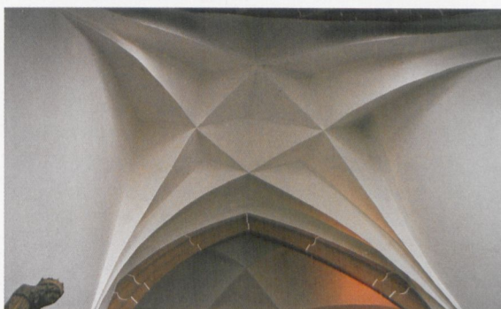
Abb. 22 Albrechtsburg Meissen, zellengewölbter Knickstern einer Fensternische.
