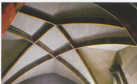
Abb. 21 St. Marien Zwickau, Knickrippenstern in der Südwesthalle.
