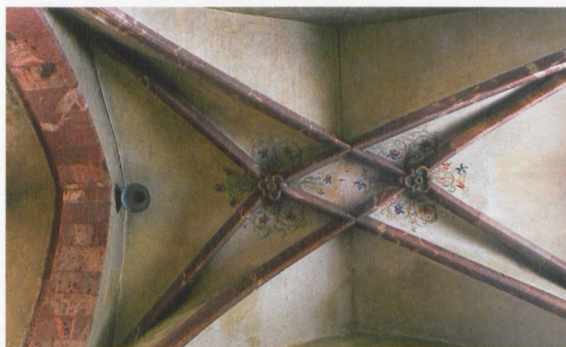
Abb. 20 Kunigundenkirche Rochlitz, Knickrippenstern im Obergeschoss des Westbaus.
