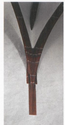
Abb. 9 Stiftskirche Wechselburg, Gewölbeanfänger des Mittelschiffgewölbes.
