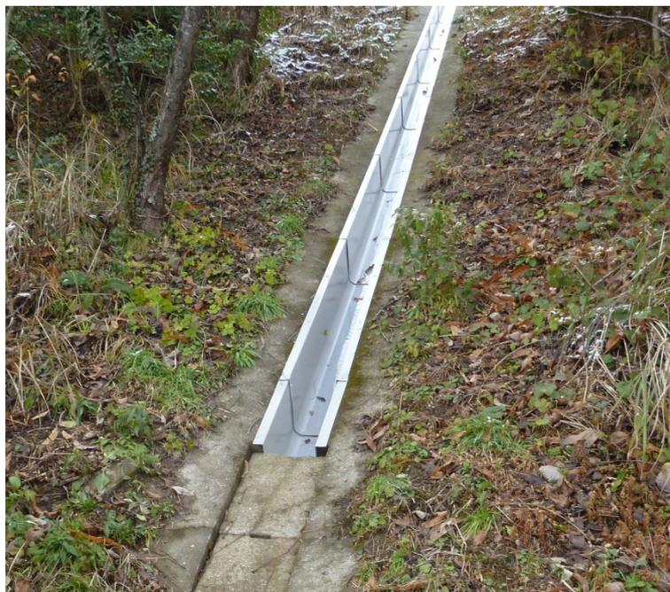
写真-5.1 FRPを使用した水路目地補修対策
