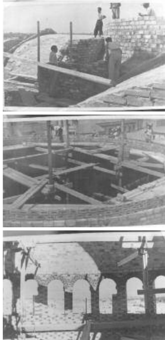
Fig. 5. Construcción de la cúpula bizantina de la Iglesia (F5.1 y F5.2) y arcos de iluminación de la nave (F5.3). Fuente: colección Antonio Serrano Bru
