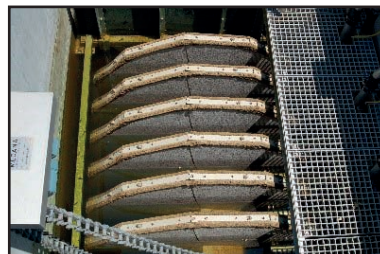
Imagen 5. Procesos de un tratamiento terciario (EDAR-ERA "Alicante Norte", Alicante): coagulación-floculación-decantación lamelar (izq.), filtración por discos de telas (centro) y desinfección por radiación UV (dcha.)
