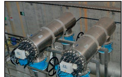
Imagen 5. Procesos de un tratamiento terciario (EDAR-ERA "Alicante Norte", Alicante): coagulación-floculación-decantación lamelar (izq.), filtración por discos de telas (centro) y desinfección por radiación UV (dcha.)
