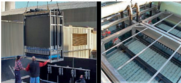
Imagen 6. Instalación de un módulo de MBR (izq.) y MBR en funcionamiento (dcha.)
