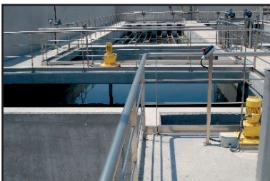
Imagen 5. Procesos de un tratamiento terciario (EDAR-ERA "Alicante Norte", Alicante): coagulación-floculación-decantación lamelar (izq.), filtración por discos de telas (centro) y desinfección por radiación UV (dcha.)
