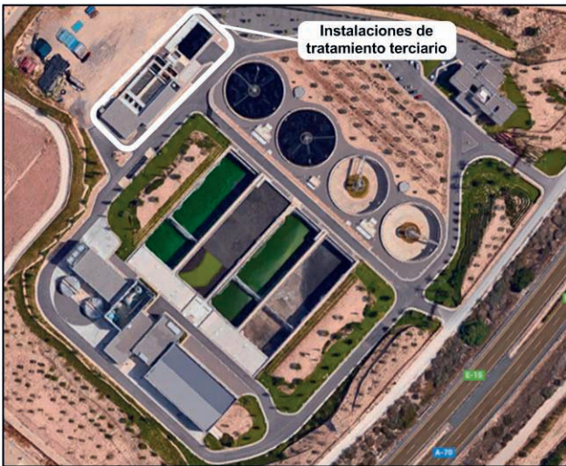
Imagen 4. Instalaciones del tratamiento terciario de la EDAR-ERA "Alicante Norte" (Alicante)
