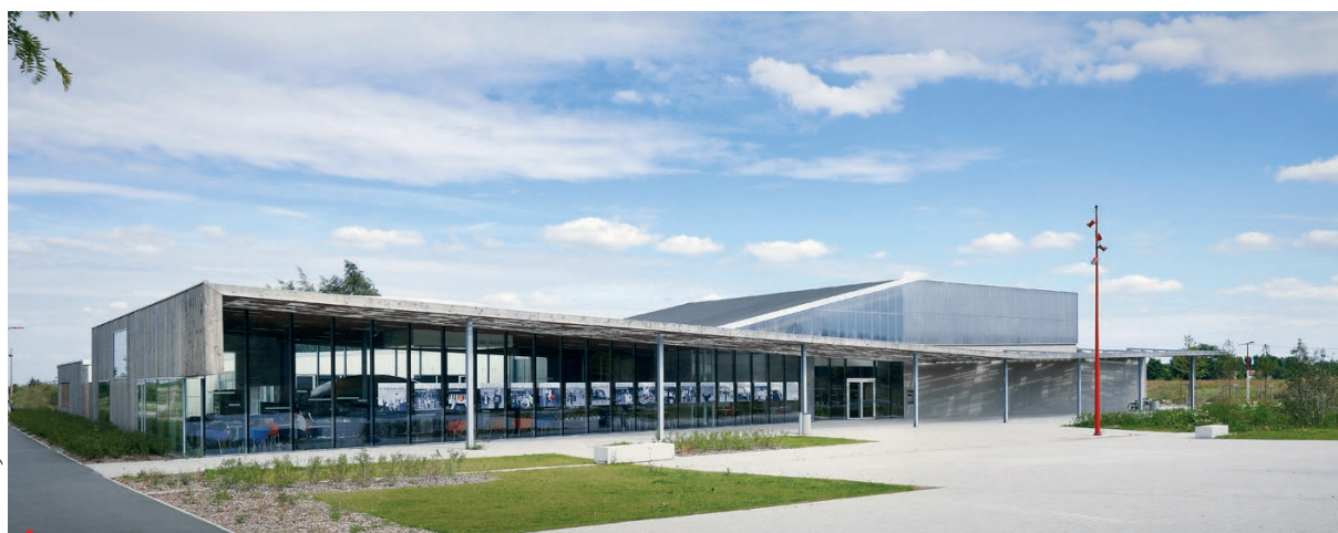
Façade avant de la médiathèque de Méricourt-sous-Lens.
