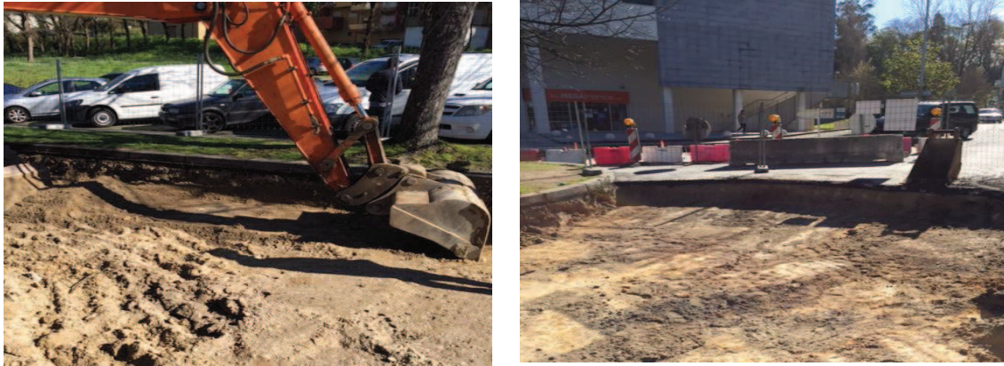
Figura 36. Trabalhos de saneamento de solos.
