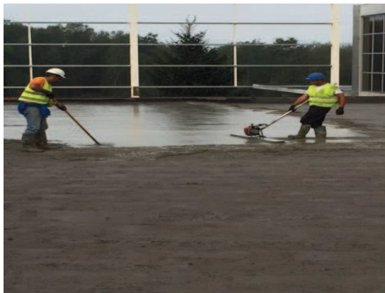
Figura 90. Trabalhos de betonagem e nivelamento da camada de regularização.
