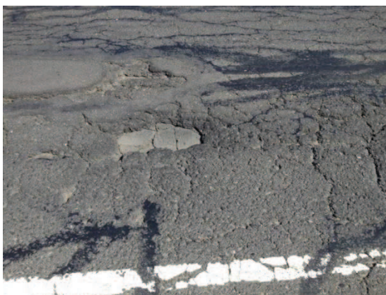
Figura 27. Desagregação do tipo “Pelada”.
