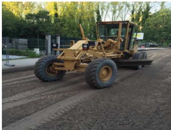
Figura 37. Trabalhos de nivelamento da camada de base em ABGE.
