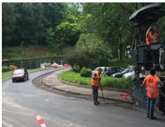
Figura 35. Trabalhos de fresagem de pavimento existente.
