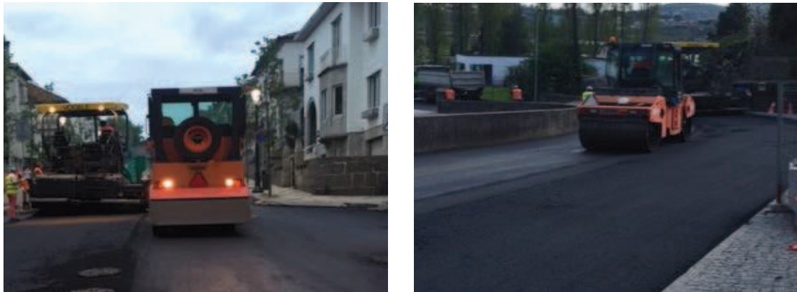
Figura 34. Trabalhos de compactação de camadas betuminosas.
