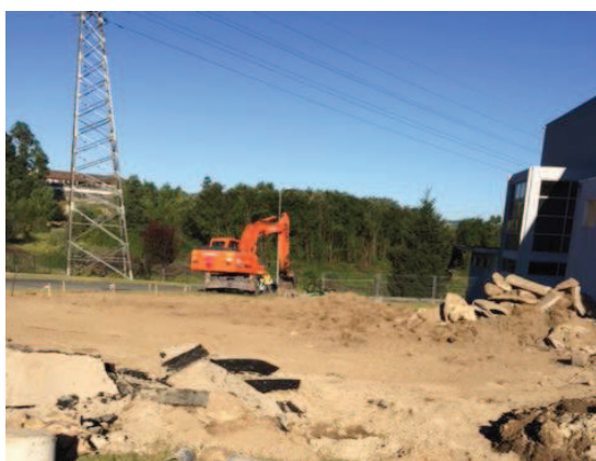
Figura 58. Trabalhos de demolição.
