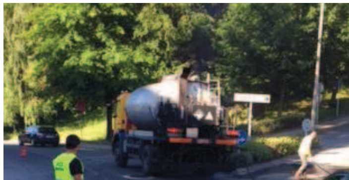
Figura 32. Trabalhos de aplicação de emulsão betuminosa.
