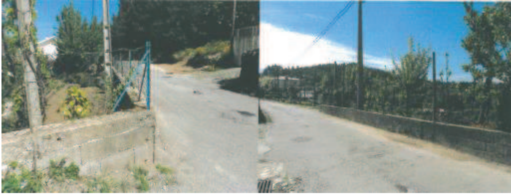
Figura 4. Zona de muro de vedação a demolir e reconstruir.
