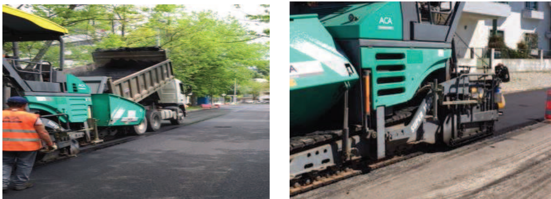
Figura 33. Trabalhos de pavimentação de camada betuminosa.
