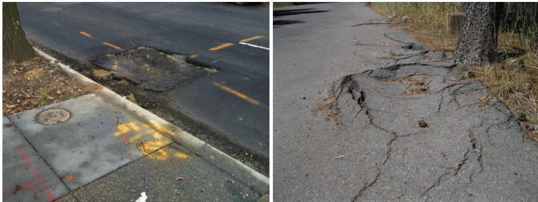
Figura 19. Deformações localizados.
