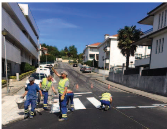
Figura 38. Trabalhos de marcação horizontal manual.
