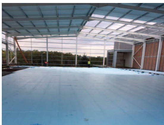
Figura 91. Trabalhos de aplicação de camada de revestimento térmico e barreira de vapor.
