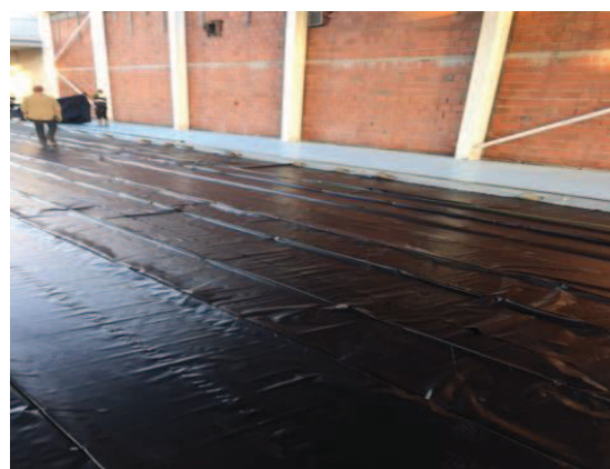
Figura 91. Trabalhos de aplicação de camada de revestimento térmico e barreira de vapor.
