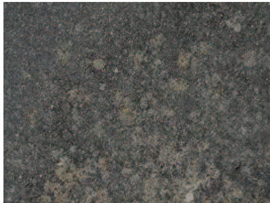
Figura 25. Desagregação superficial.
