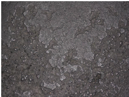
Figura 26. Desagregação tipo “cabeça de gato”.
