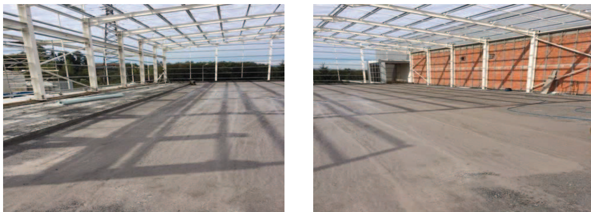
Figura 89. Finalização da compactação da camada de base.
