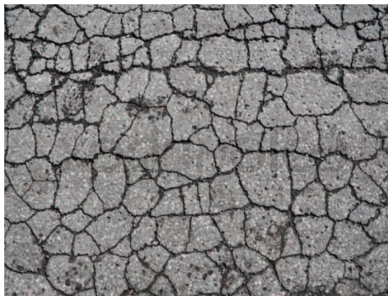
Figura 24. Fendilhamento tipo pele de crocodilo.
