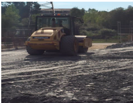
Figura 86. Trabalhos de compactação do solo de aterro.
