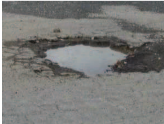
Figura 28. Desagregação do tipo ninho.
