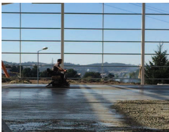
Figura 92. Trabalhos de talochamento mecânico com equipamento “helicóptero”.
