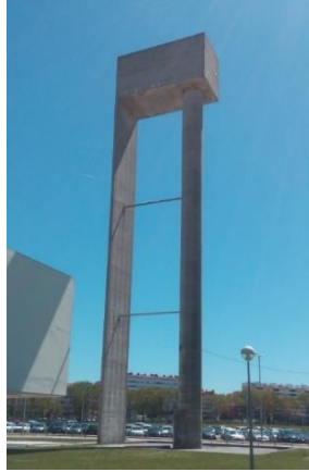
Figura 4.1 - Depósito de água da Universidade de Aveiro.
