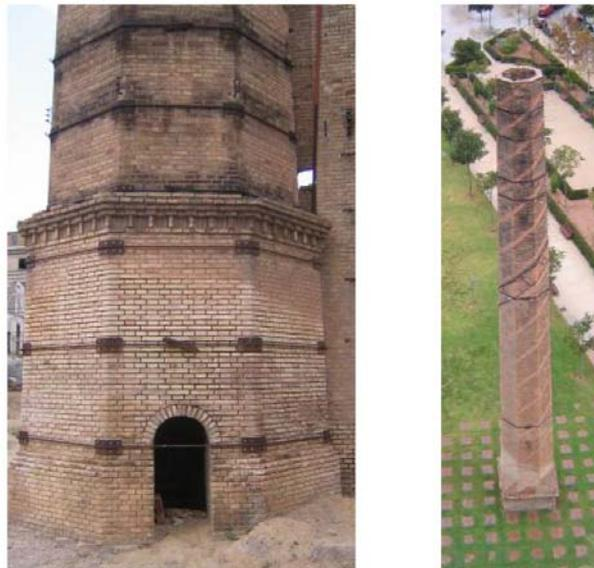
Figura 3.31 –Aplicação de cintas metálica para reforço de chaminés de alvenaria. (Ivorra, 2014)
