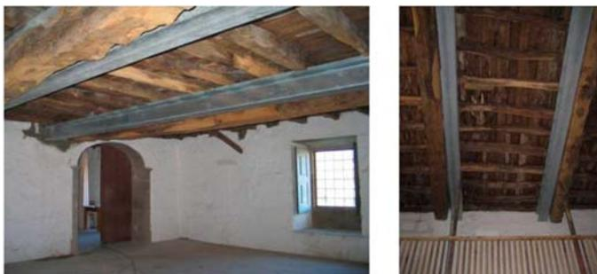
Figura 3.23 – Exemplo de aplicação de vigas paralelas ao vigamento de madeira (costa et al., 2014)
