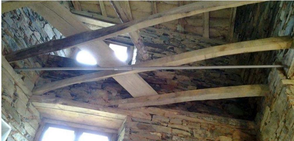
Figura 3.1 - Tirante passivo em paredes de alvenaria (Planirest.pt, n.d.)
