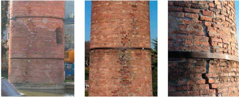
Figura 3.30 –Fissuração em chaminés de alvenaria. (V. A. M. Lopes, 2009)
