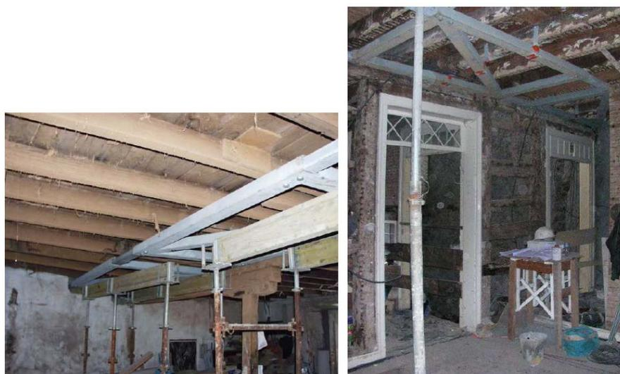
Figura 3.9 – Viga treliça colocada em posição central ( Barros, 2005).
