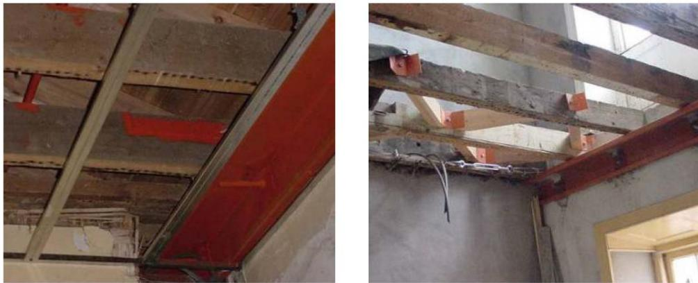
Figura 4.13 Melhoria da ligação parede pavimento com cantoneiras quinadas (Ilharco, 2008).
