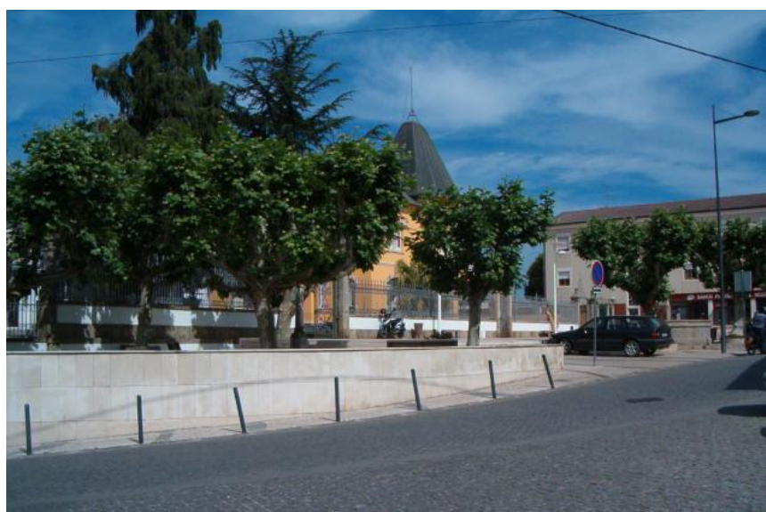
Figura 14. Praça da República, na Vila de Angeja, já reabilitada;
