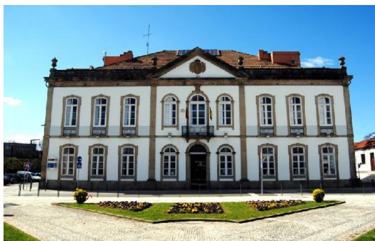
Figura 2. Vista geral da fachada principal da Câmara Municipal (2015);
