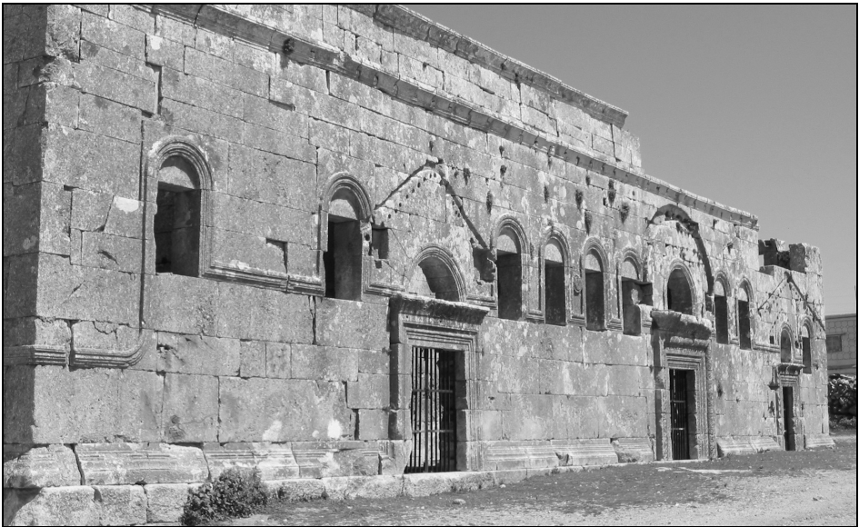
Fig. 7. Qalb Loze, south façade (photo: M. Bogisch).
