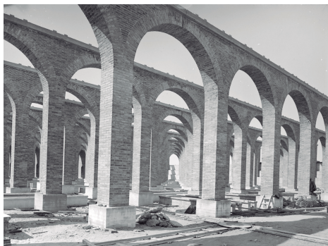
f6_Tercer Depósito Canal de Isabel II
