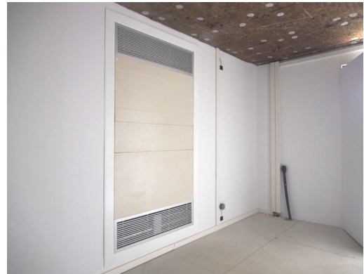
Figura 5: Fotografía de la instalación del sistema de climatización termoeléctrico en la fachada suroeste del prototipo 2.1.
