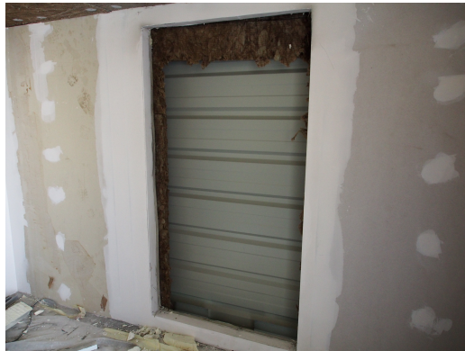
Figura 5: Fotografía de la instalación del sistema de climatización termoeléctrico en la fachada suroeste del prototipo 2.1.
