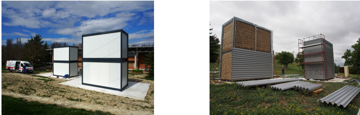
Figura 4: Fotografía del proceso de construcción de los dos prototipos de ensayo.
