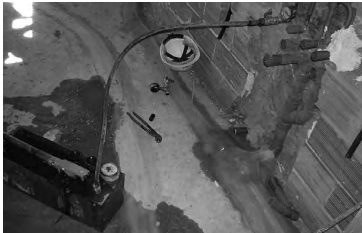
Fig. 16. Realización de las pruebas de resistencia mecánica y estanqueidad en instalaciones de agua fría y caliente de nueva construcción
