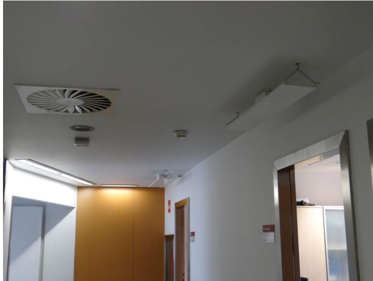
Figura 10. Instalación de antenas RFID.
