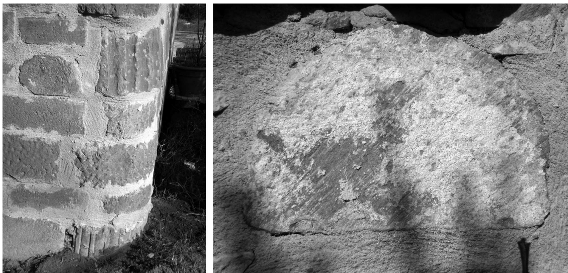
Fig. 11. Detalle de algunos materiales arquitectónicos reutilizados en el Corral del Boticario, en Campo Real/Fillera.
