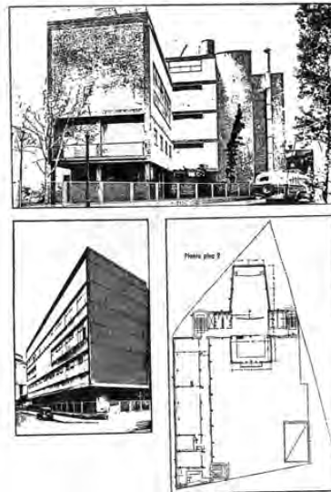
1934-1936. Josep Ll. Sert, Josep Torres Clavé y Joan B. Subirana. Dos fachadas del "Dispensari Central Antituberculós" en la calle Torres Amat, Barcelona, la obra más importante del racionalismo español.
