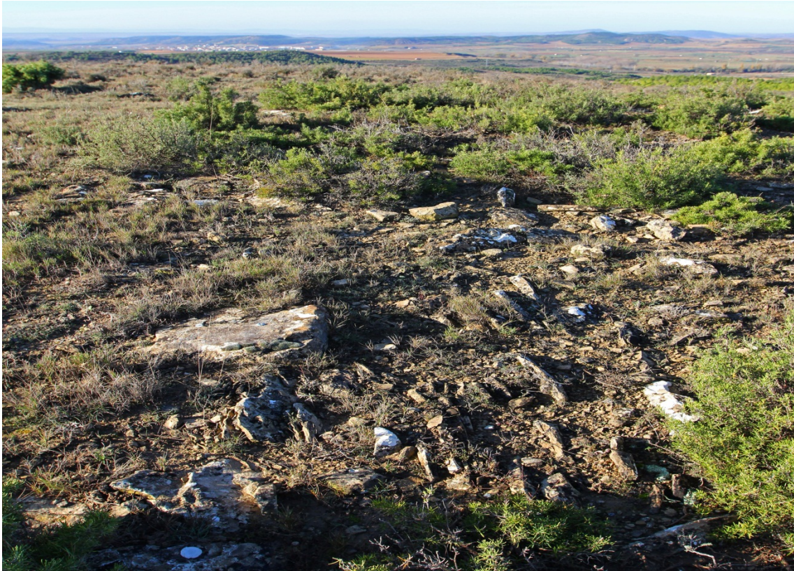
Figura 19 Posible derrumbe del murete del túmulo
