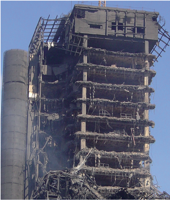
Edificio Windsor, Madrid (2005)
