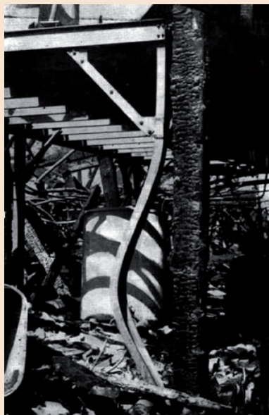
Pilar de acero y madera tras un incendio.
