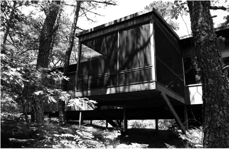
Fig. 15. Fachada sur cabaña Breuer. Wellfleet. (Fotografía: Luis de Fontcuberta, julio 2011).
