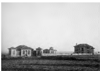
Los pabellones construidos por Antonio Flórez para las escuelas de la Fundación González Allende de Toro (Zamora). Archivo de la Alhambra, Granada.
