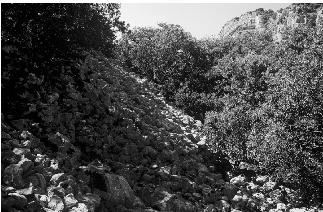
Figura 10. Primer plano del derrumbe de la muralla del castro de la Peña Bardagorría. Al fondo, el oppidum de Altikogaña en la peña del mismo nombre.
