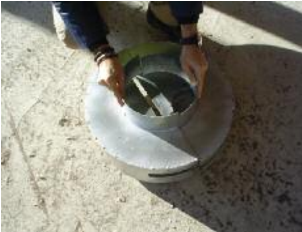
Figura 7. Pieza de transición entre el conducto de chapa y la parte superior del SGM (Fot. C. Martín Gómez).
