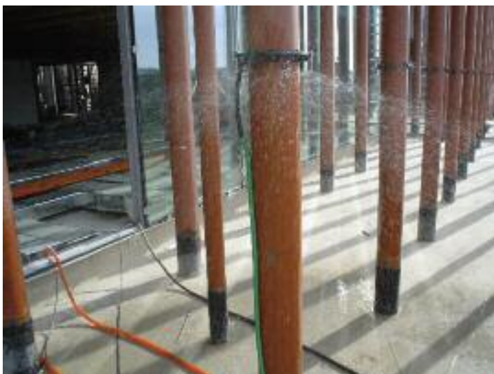
Figura 6. Rociadores de agua de los SGMs: prueba de mojado y montaje (Fot. C. Martín Gómez).
