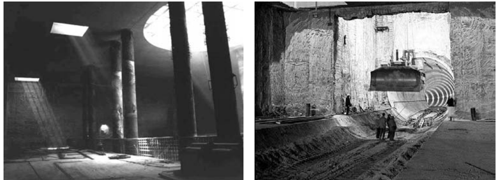
Fig. 6 y 7. Fotos de las obras de Metro Sur, Madrid, 2003. (Consortio de Transporte de Madrid.)
