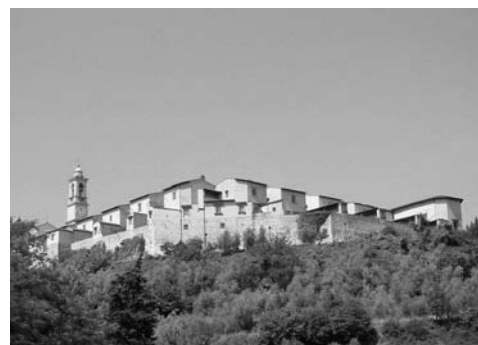
Fig. 13. Las celdas de la Cartuja de Ema vistas desde la colina (fotografía del autor).
