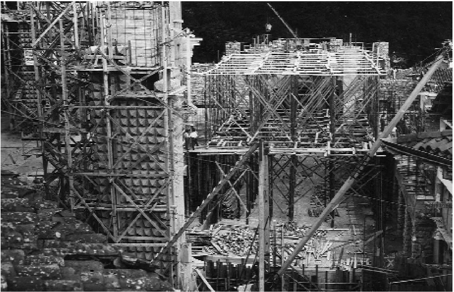
Fig. 4. Vista general de las obras con el arranque de la armadura de cubierta sobre el techo de la cripta, agosto 1952. Fotografía: J. L. Plazaola.
