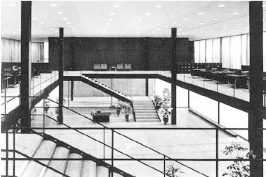
Fig. 4. Mies Van Der Rohe. Ron Bacardí y Cía, S.A., Edificio Administrativo (México D.F.).
