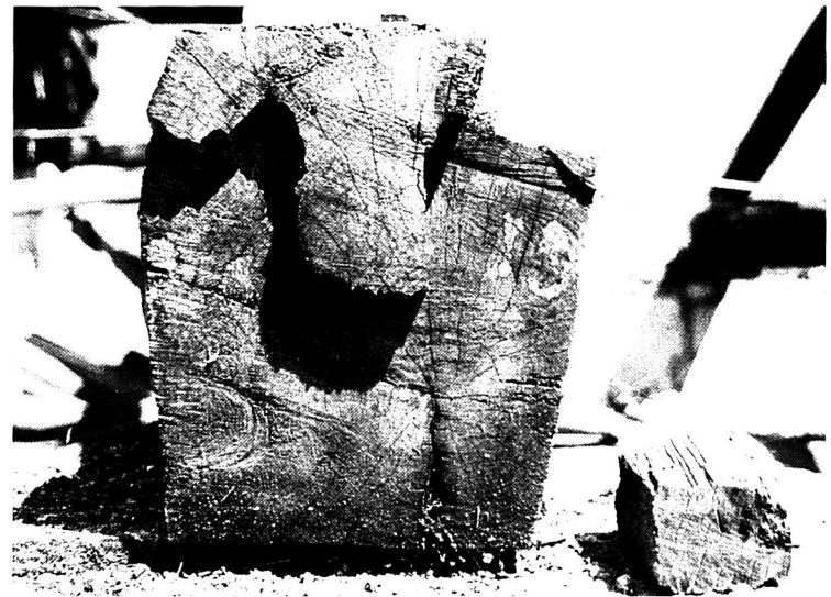
Vista de la rotura del talón del embarbillado a cortante, por falta de longitud. La forma de la rotura sigue la forma de la espiga del embarbillado
