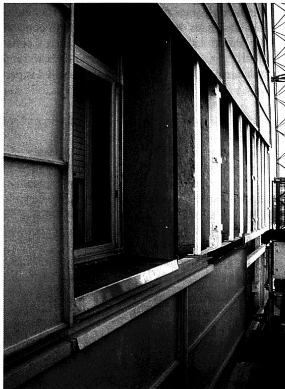
1 Anclaje de acero inoxidable de los paneles de cobre E=5mm 2 Pasador de acero inoxidable 3 Chapa de acero inoxidable E=2mm para refuerzo de tablero contrachapado.
