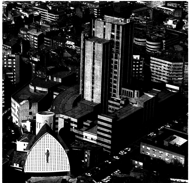
Aspecto del hospital antes del comienzo de las obras de rehabilitación de la fachada
