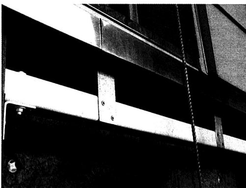
Sistema de anclaje de los paneles de fachada
