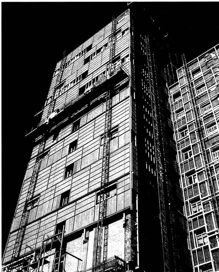
Proceso de ejecución de la subestructura de fachada
