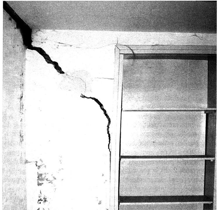
Vista interior de la vivienda
