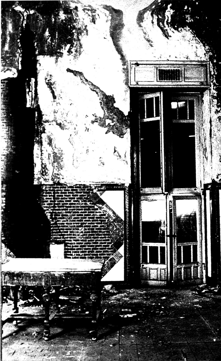
Hospital de Maudes. Estado previo a la rehabilitación
