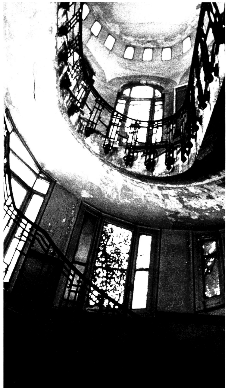
Hospital de Maudes. Estado inicial
