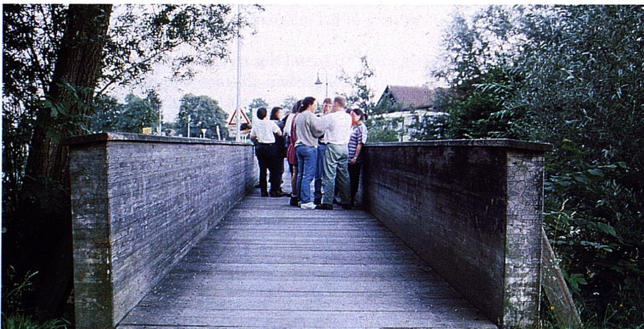
Pieza de remate y protección del borde superior de la viga. El corazón queda hacia arriba para impedir la aparición de las fendas de secado en la cara superior.
