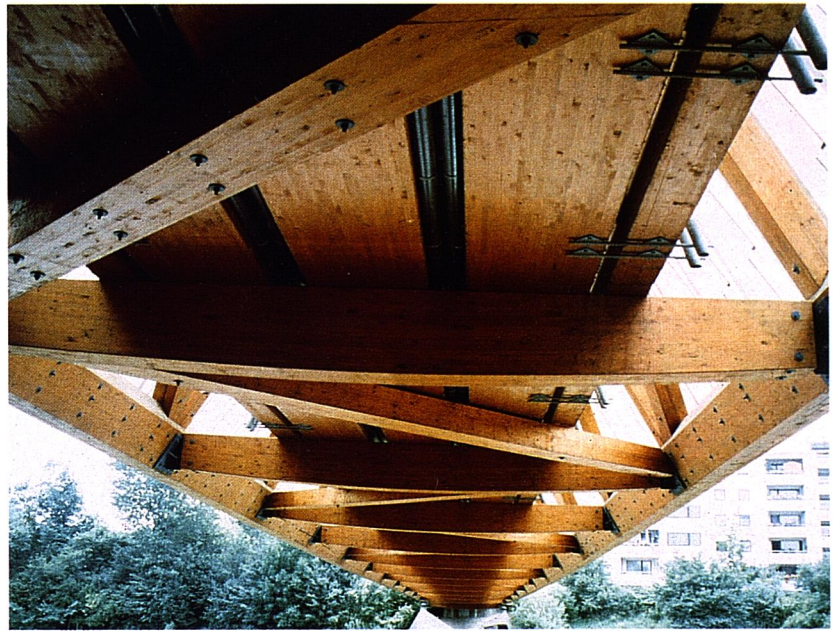
Celosía inferior en la que se aprecian las tres piezas de madera laminada que sirven de soporte al entablado.
