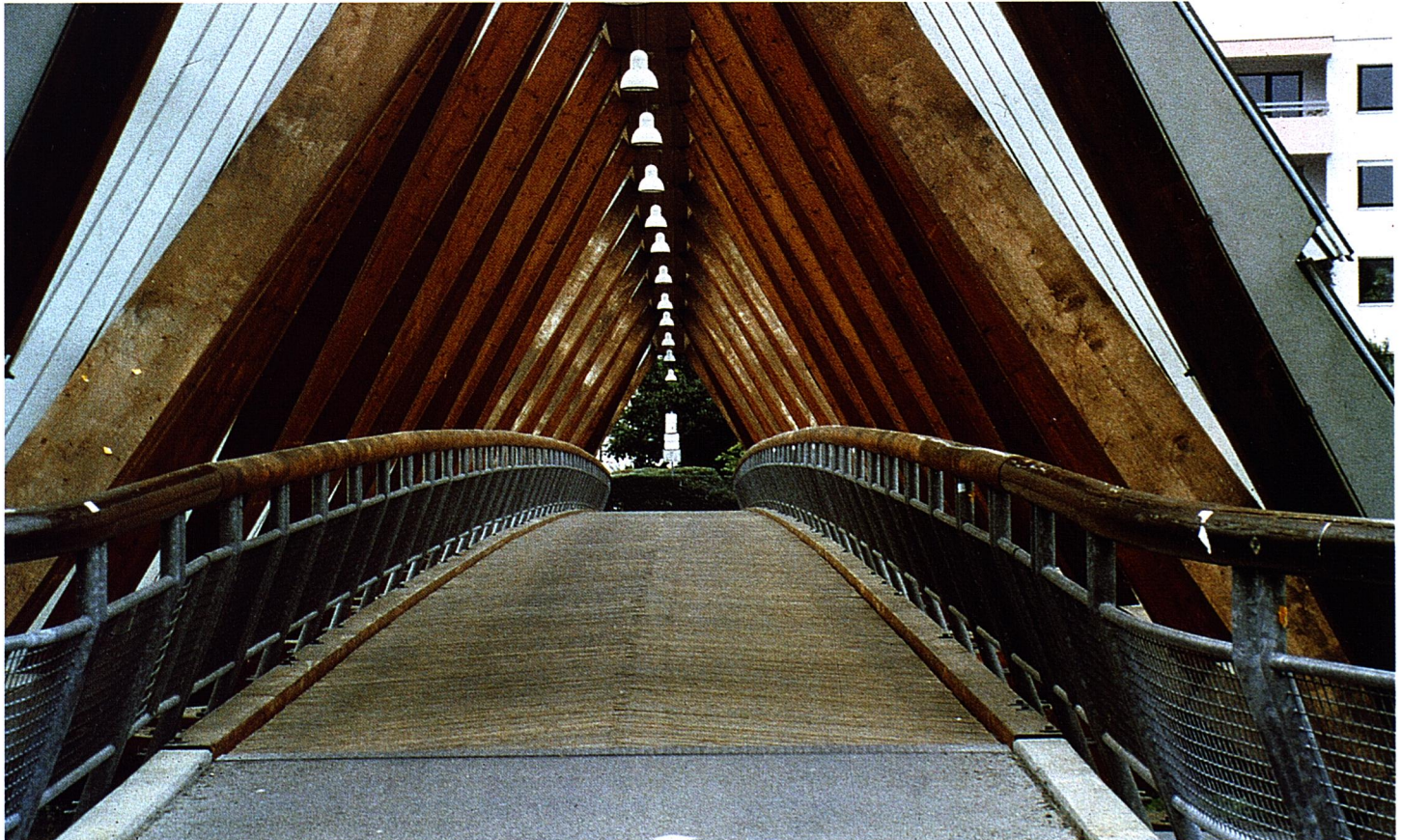
Vista interior en la que se observa la contraflecha de ejecución.
