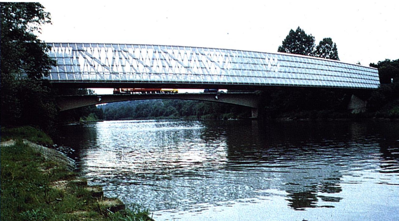
Vista general de la pasarela de Remseck.
