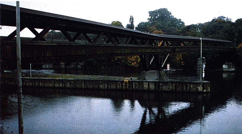
Vista general de la pasarela de Stuttgart. Sistema estructural en celosía de madera laminada encolada.
