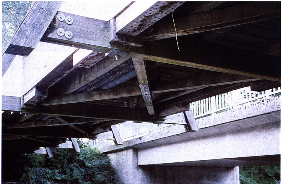
Vista de la celosía inferior. Los montantes quedan colgados de las vigas principales y los tacos de madera clavados permiten la transmisión de los esfuerzos rasantes en el punto de encuentro de las dos diagonales.
