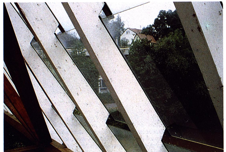
Encuentro de las barras de la celosía en el vértice superior.
