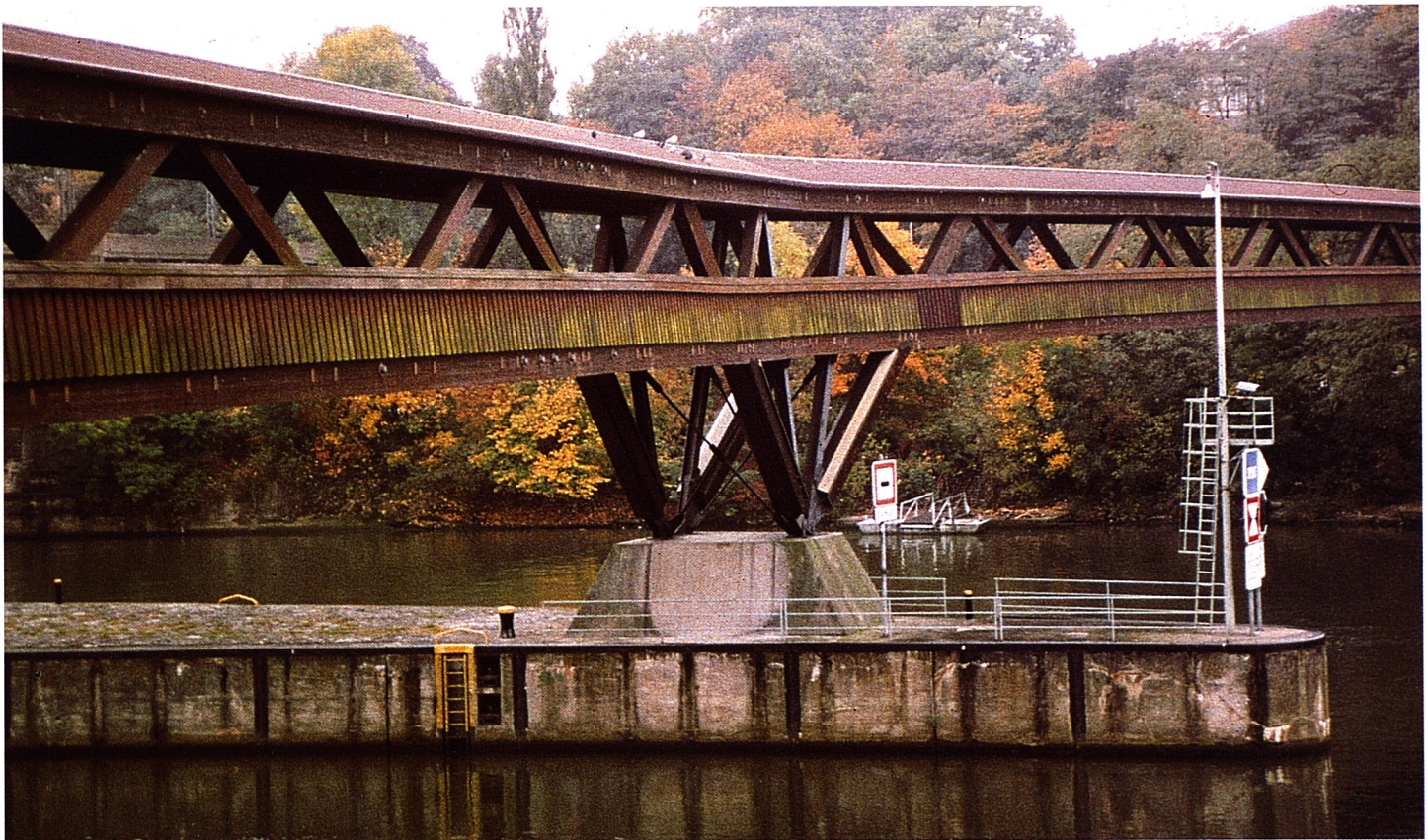
Apoyo central que se materializa con dos piezas de madera laminada formando una V, reforzado con otras dos piezas de acero en una V más cerrada.
