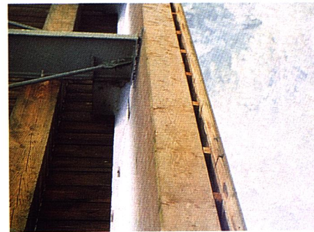
Vista del entablado de protección fijado sobre un enrastrelado a la cara de la viga principal.
