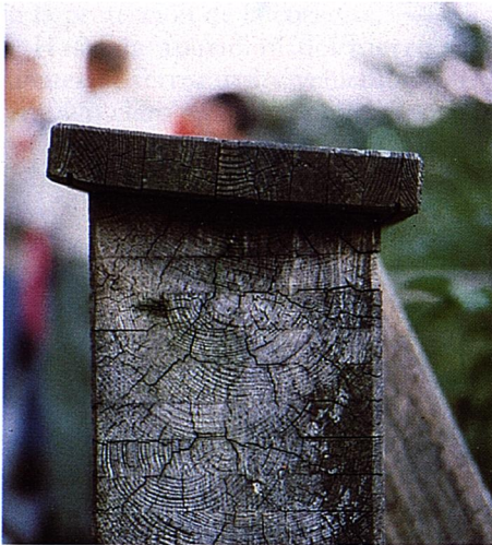
Pieza de remate y protección del borde superior de la viga. El corazón queda hacia arriba para impedir la aparición de las fendas de secado en la cara superior.
