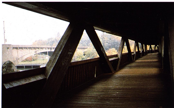
La estructura de celosía es visible desde el interior. En el apoyo central, la dirección de la pasarela se quiebra para evitar una excesiva longitud visual, además de poder observar desde el interior la propia fachada del puente.
