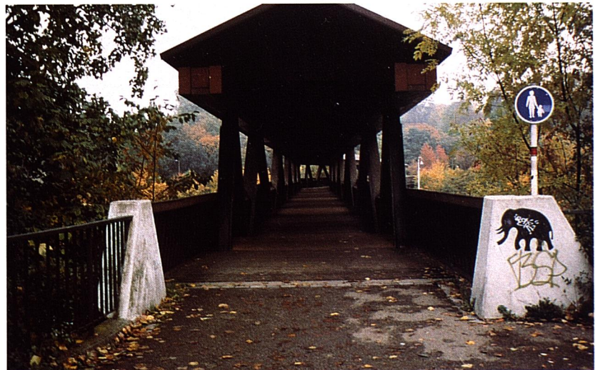
Arranque de la pasarela en el que se aprecia que la cubierta se retrasa varios metros respecto a la entrada. Pueden apreciarse las secciones compuestas de los cordones superiores.
