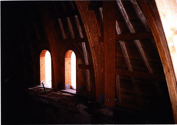
4. Interior de la cúpula.
