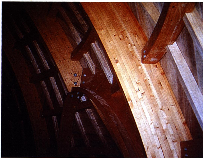
3. Interior de la cúpula desde el suelo.
