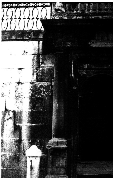
Figura 5 La incorrecta evacuación de las aguas de cubierta puede provocar lavados diferenciales en fachadas que, independientemente del peligro de penetración de agua en el interior de la piedra, produce un efecto antiestético. (Catedral de Jaén).
