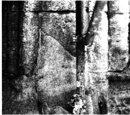
Figura 4 Preconsolidaciones mediante gasa y resina acrílica paraloid B-72 (Iglesia de Santa Ana, Sevilla)
