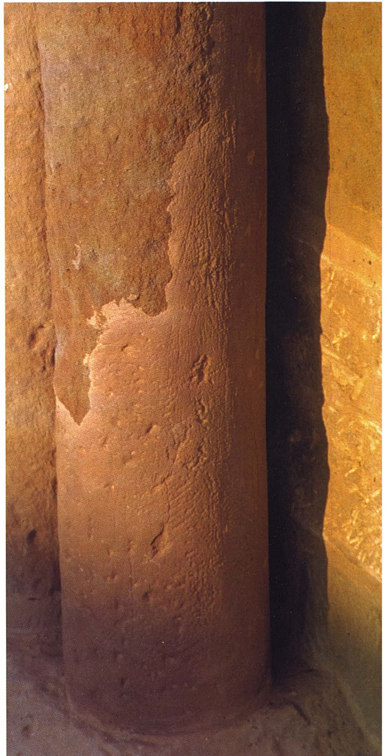
La incorrecta restitución tanto por su forma como por la utilización de veladuras puso en crisis la utilización de un mortero extranjero de máximo prestigio, pero pensado para piedras de su país de origen. Una reparación más ajustada a un despiece constructivo, quizás también hubiera quedado en evidencia, pero de una manera más correcta. Pensemos que la piedra no se hace nace
