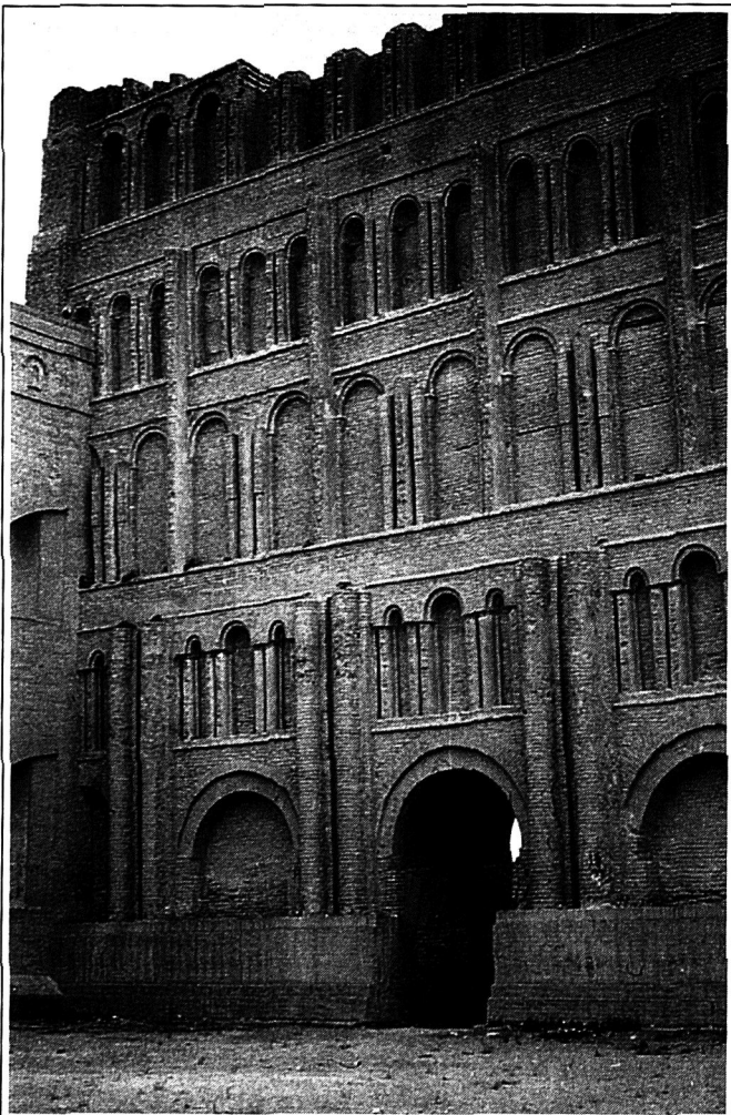
Figura 6 Fachada del Palacio. Situación actual
