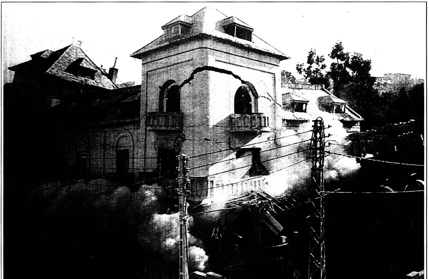
Figura 5 Voladura controlada
