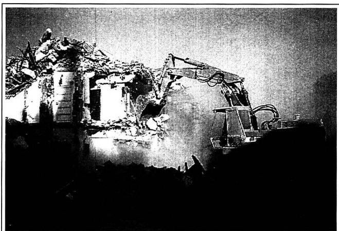
Figura 7 Empuje mediante cuchara
