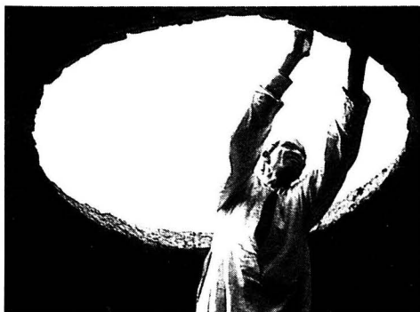
Albañiles nubios cerrando una cúpula (1, 2) y una bóveda (3) para la Casa Greiss de Hassan Fathy.
