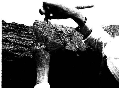
Albañiles nubios cerrando una cúpula (1, 2) y una bóveda (3) para la Casa Greiss de Hassan Fathy.
