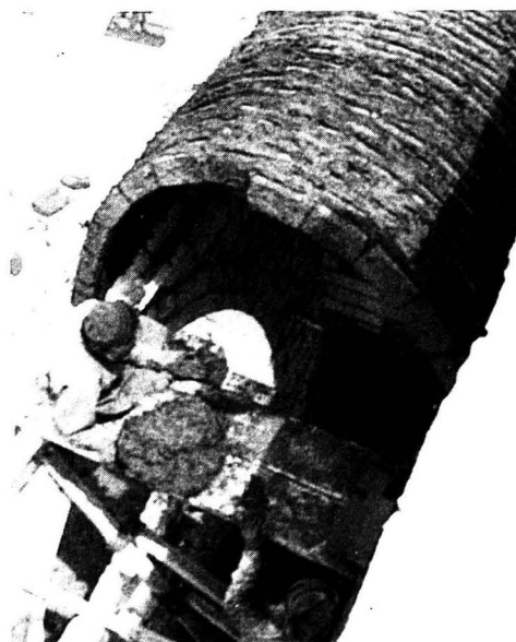
Albañiles nubios cerrando una cúpula (1, 2) y una bóveda (3) para la Casa Greiss de Hassan Fathy.
