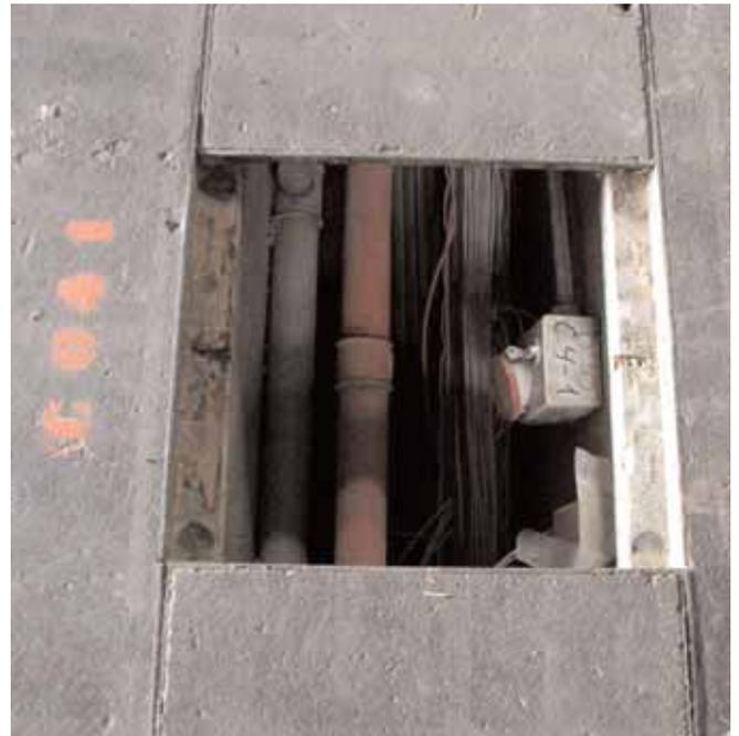
Interior de un canal de servicios donde se aprecia la tubería de incendios, la tubería de fontanería, la red eléctrica y la red de datos (fot. J. Terés)
