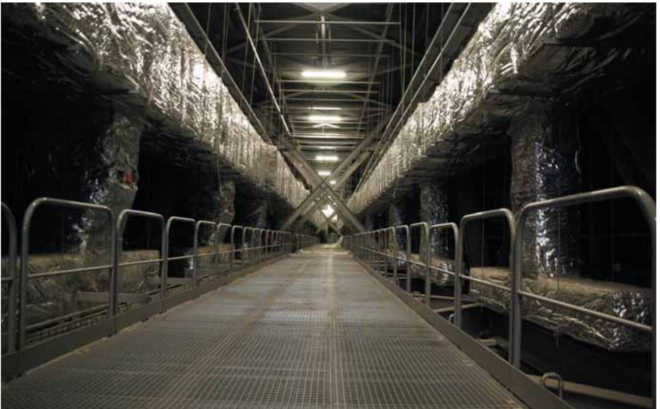
Interior de una jácena con los conductos de climatización. Obsérvense las embocaduras a las toberas de impulsión de aire (fot. J. Terés)
