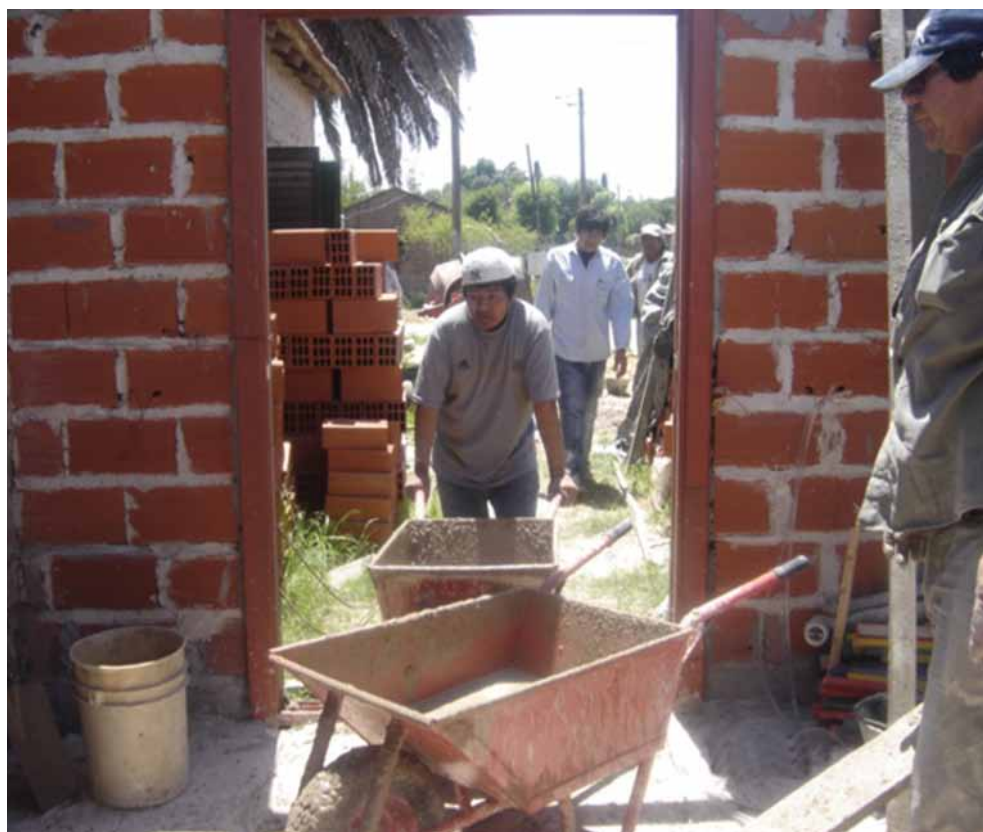
Autoconstrucción de la Casa de la Cultura Qom, en el barrio Las Malvinas.
