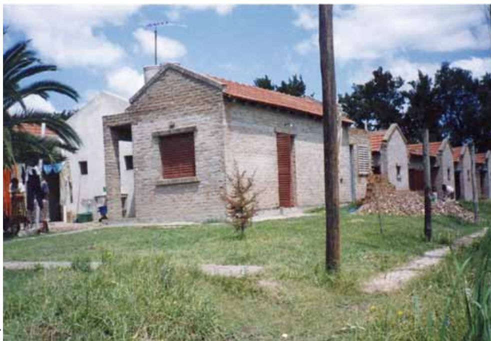
Viviendas autoconstruidas del sector norte del barrio.
