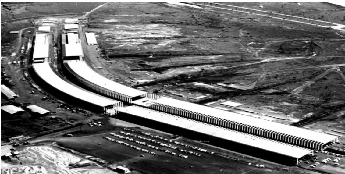
Fotografia 6 – Construção do Instituto Central de Ciências/UnB
