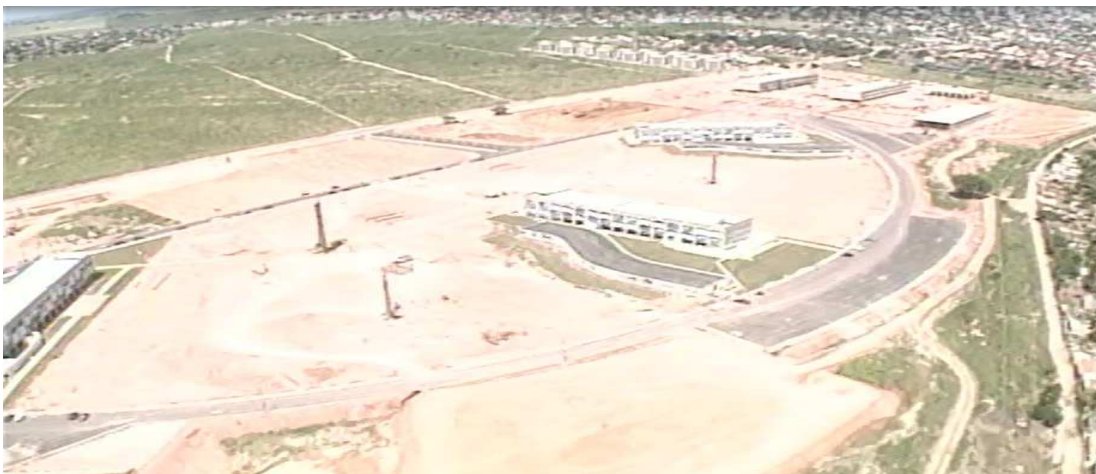
Início das obras de construção da UENF
