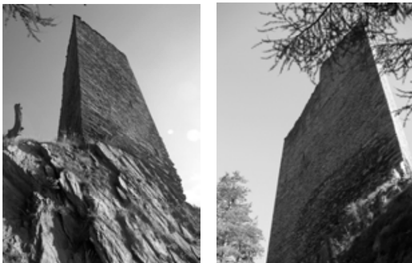
Abb. 11a–b: Mauerwerk der Südwestflanke (l.) und Nordflanke (r.) von Ruine Haldenstein. Foto Krytyna & Thierry Greub
