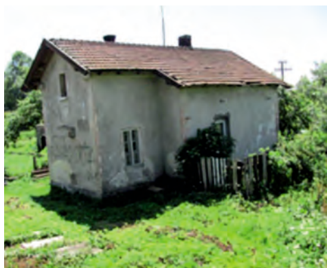
Fot. 23. Budynek ok. stacji Chodorów/ Chodoriw. Galicja
