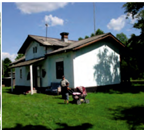
Fot. 6. Dworzec Kupka Bukowina Północna
