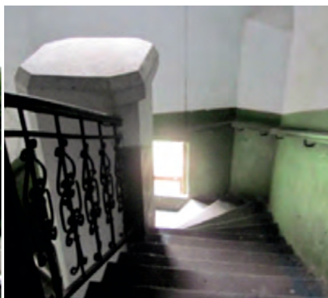
Fot. 8. Schody mieszkaniowe na dworcu Komarno
