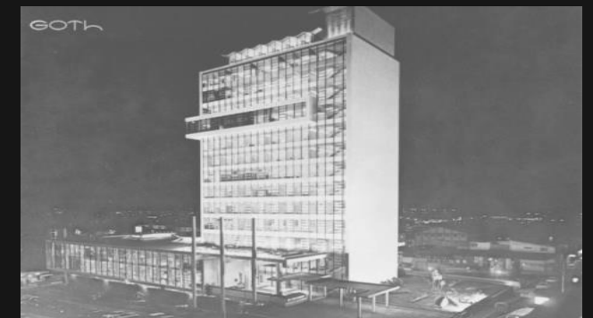
Imagen 3. EDIFICIO DE LA CCSS.
