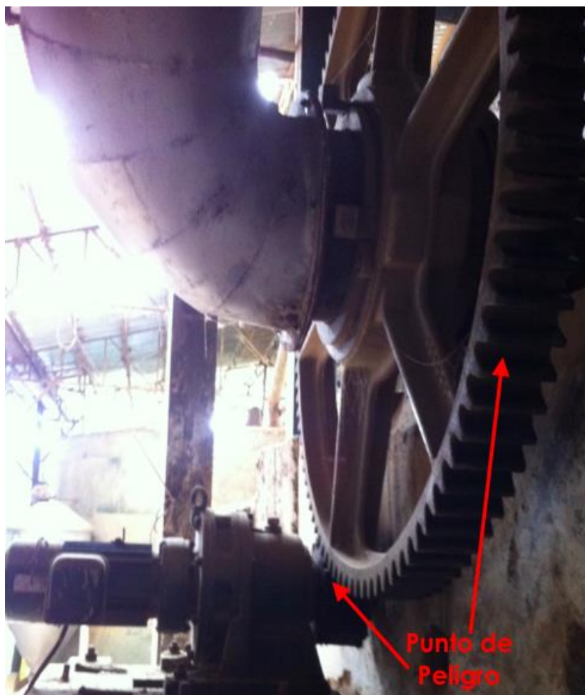
Figura IV-15: Ilustración del punto de peligro de la Guardiola
