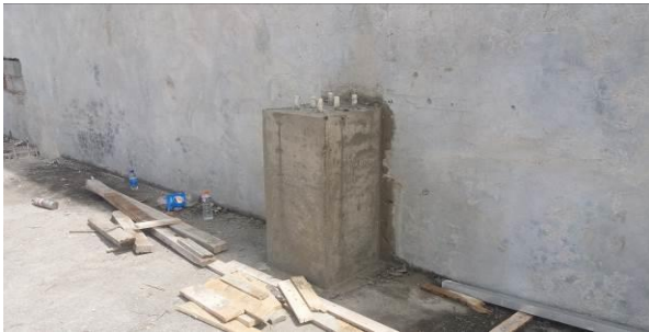
Figura 31. Pedestales de las columnas CC-3
