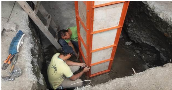
Figura 28. Encofrado de columnas con paneles confeccionados in situ.
