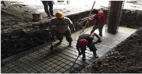
Figura 18. Chorra de cimentación CC-1
