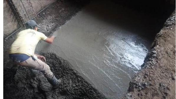
Figura 15. Colocación del sello de nivelación.
