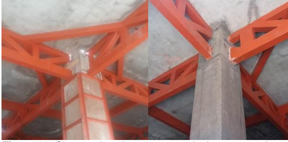
Figura 30. Chorrea de columnas parte alta hasta entrapiso.
