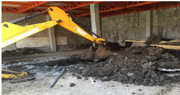
Figura 12. Excavación de columnas centrales (CC-1).
