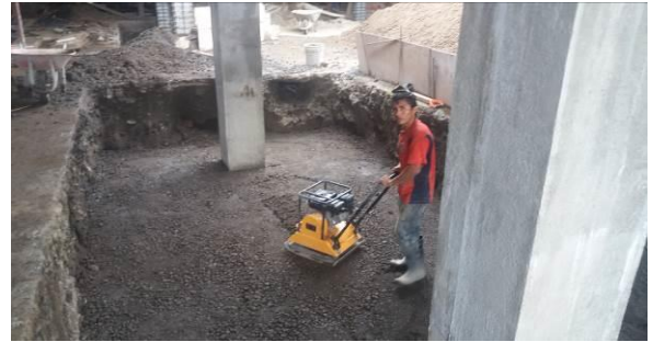
Figura 32. Compactación de las primeras capas de lastre
