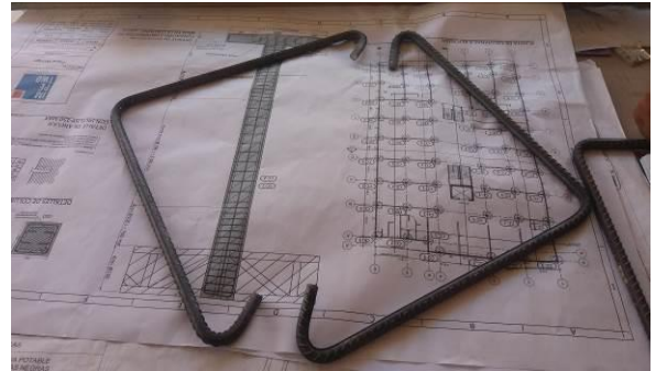
Figura 20. Aros de las columnas CC-1.
