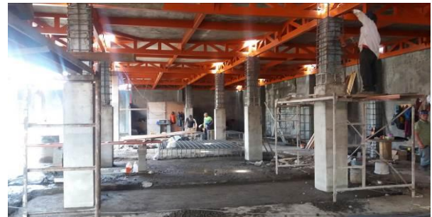
Figura 29. Chorrea de columnas hasta 3 metros de altura.
