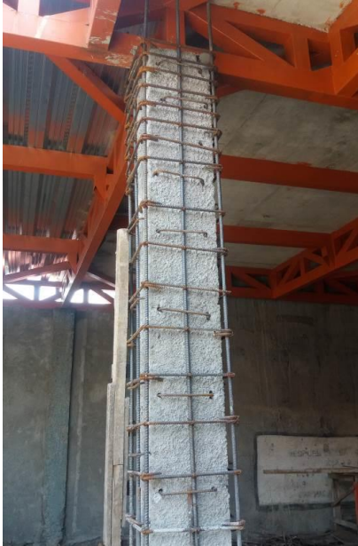
Figura 25. Colocación de ganchos "U"
