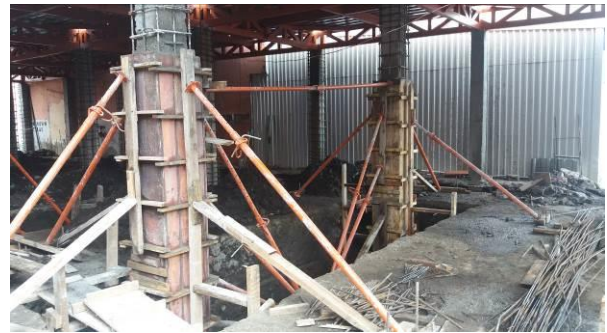
Figura 27. Encofrado de columnas con madera.
