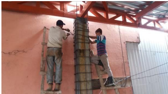
Figura 23. Armado de las columnas CC-2.
