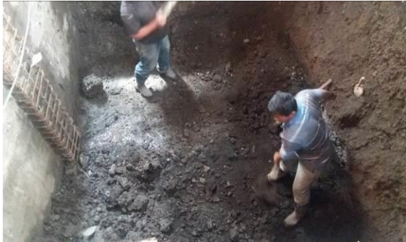
Figura 14. Limpieza y arreglo de los huecos.
