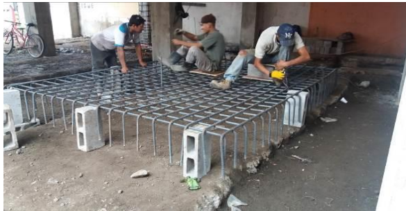
Figura 17. Armado de cimentaciones de columnas CC-3
