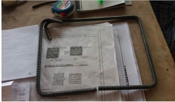
Figura 22. Aros de las columnas CC-2.
