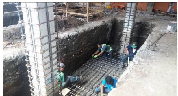
Figura 16. Armado de cimentaciones de columnas CC-1
