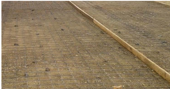
Figura 34. Colocación de malla electrosoldada.
