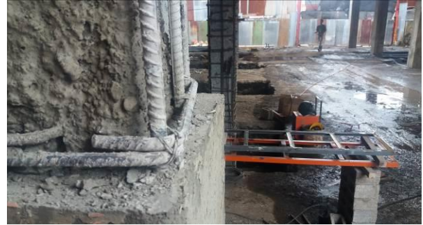
Figura 26. Columna girada sobre su eje.
