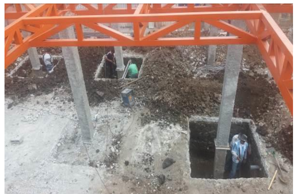
Figura 11. Excavación a mano de las columnas.
