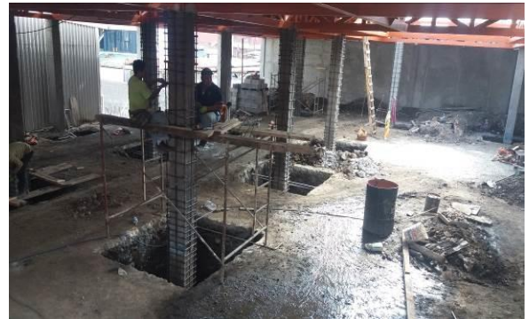
Figura 21. Armado de las columnas CC-1.
