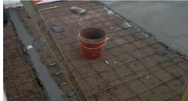
Figura 35. Chorrea de contrapiso.
