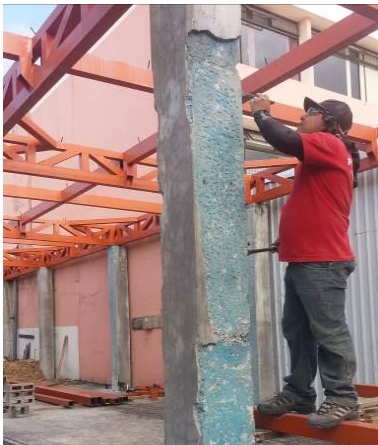
Figura 19. Remoción del repello a las columnas.
