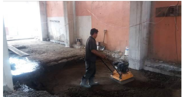
Figura 33. Compactación de lastre de las últimas columnas.
