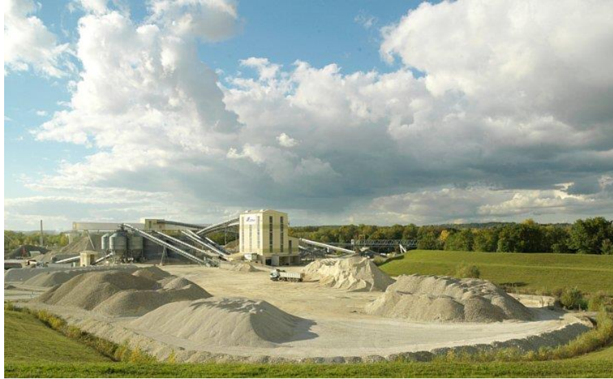
Figura 1.5.3. Cantera de agregados CEMEX (Imagen ilustrativa).
