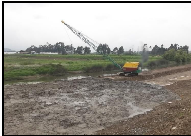
Figura 8. Extracción sedimentos de fondo
